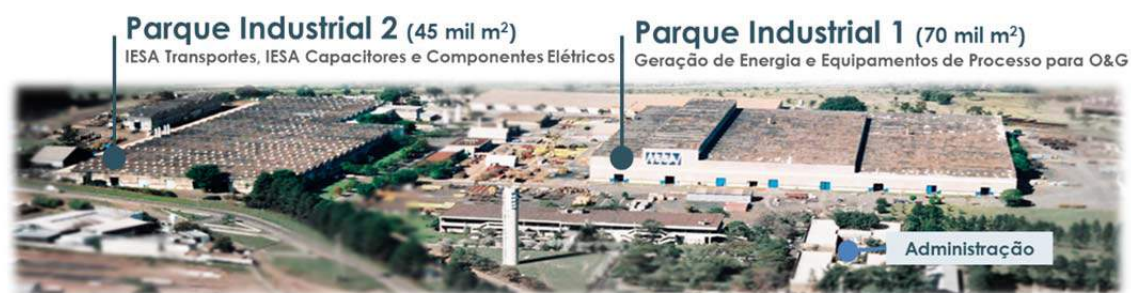
Figura 4: Parque Industrial de Araraquara
